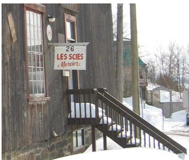
Identification sur le bâtiment
